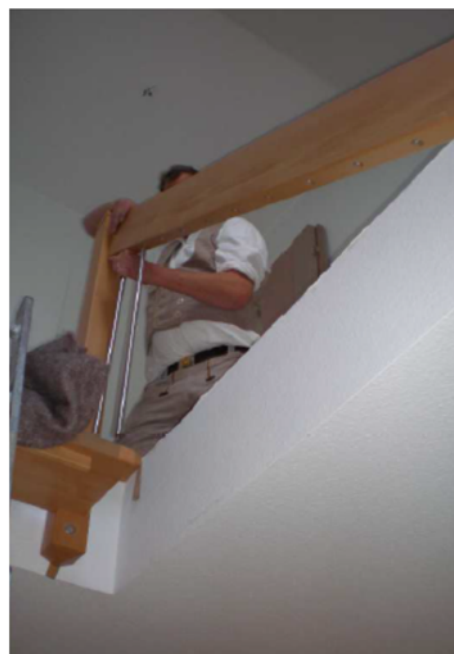
28c. Oberer Handlauf: die beiden letzten Stäbe
