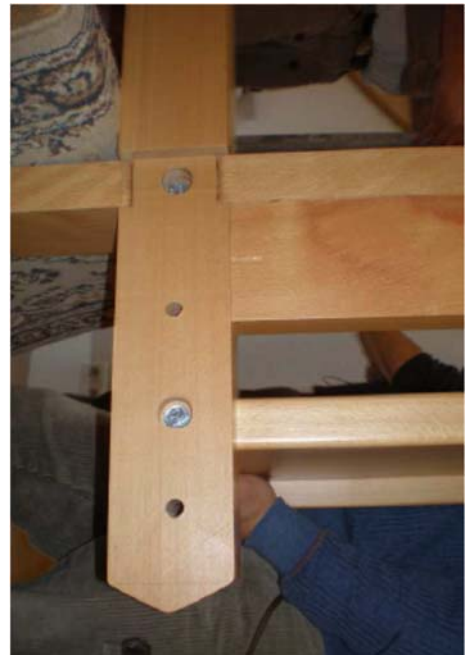
16. Vorletzte Stufe Austrittsposten montieren
