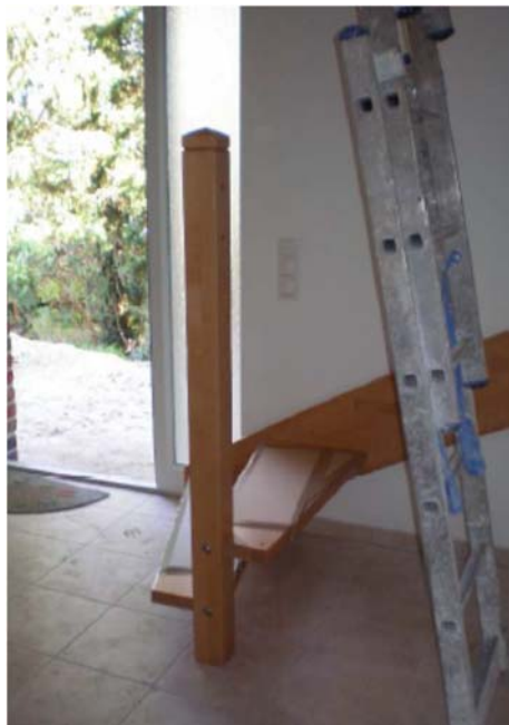
28b. Unterer Handlauf: erster Stab
