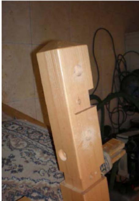
15b. Austrittsstufe-Pfosten montieren
