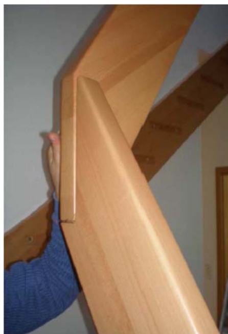
29b. Handlauf verschrauben
