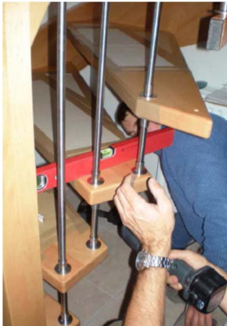
32b. Stufen waagrecht verspannen
