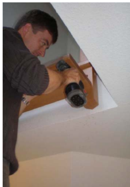
18c. Austrittselement montieren
