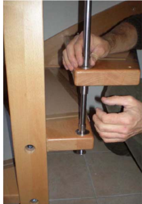
32a. Stufen mit Abstandshülsen verschrauben
