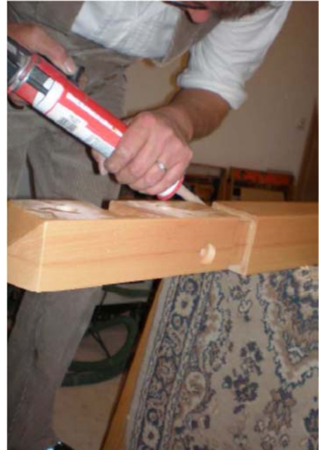
16. Vorletzte Stufe Austrittsposten montieren
