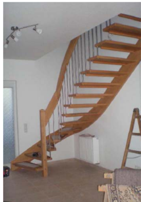
33a. Fertigstellung von unten
