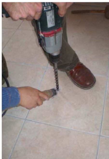
22. Fliese anflexen und bohren
