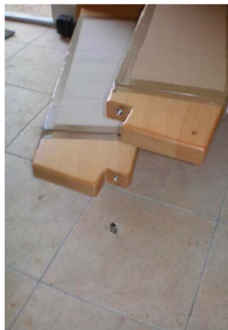
25b. Antrittsstufen vormontieren
