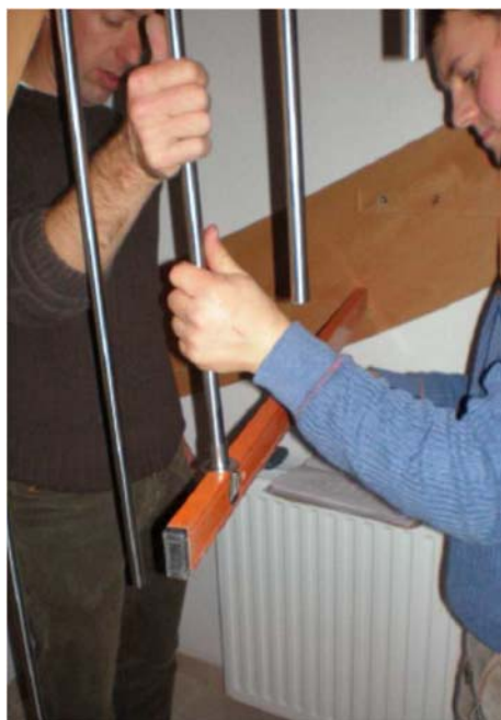
30. Alle Stäbe waagrecht einsetzen
