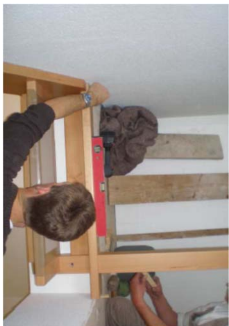
18b. Austrittselement ausrichten
