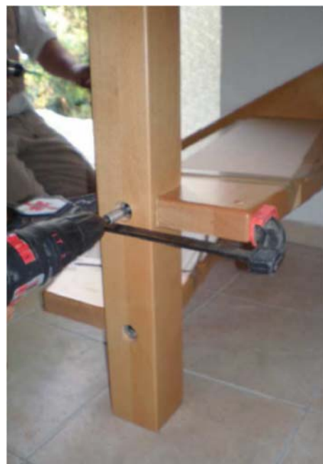
27a. Antrittspfosten einsetzen
