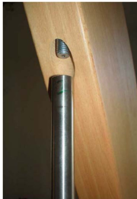
28a. Geländerstäbe nummeriert einsetzen
