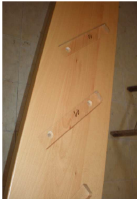
4. Wangen vorbohren (Wandmontage)
