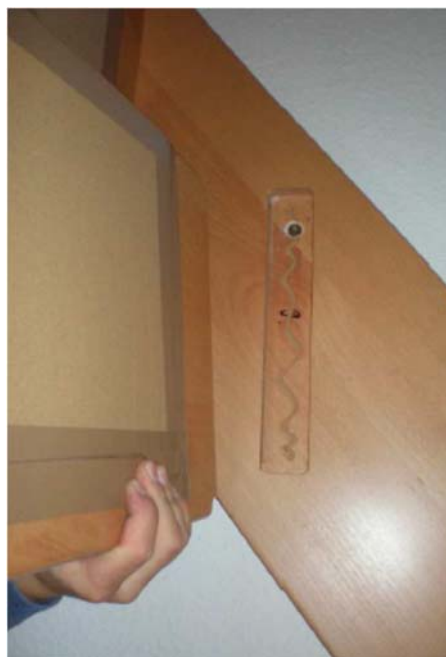
31a. Stufen einsetzen
